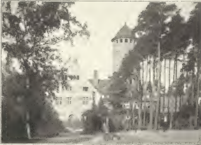
Wendgräben (12): Blick auf die Ostfront des Schlosses. In der Mitte die berankte Pergola erkennbar, links der anschließende Garten, rechts Kiefernforst mit Unterholz und Heidebodendecke.
